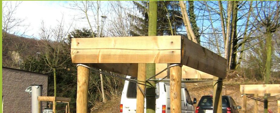
Planche en traité classe IV VERT (qualité charpente, brut de sciage, coupée d'équerre) pour réalisation de tuteurages bipodes, tripodes ou quadripodes.
