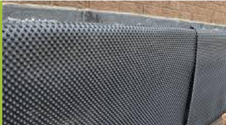
**Description :** En polyéthylène la Protection Soubassement Plus permet le drainage de l'eau lors de l'utilisation de traverses en retenue de terres. La lame d'aire entre les alvéoles et le support assure une isolation parfaite contre l'humidité. Grande résistance à la traction, pose simple et rapide
